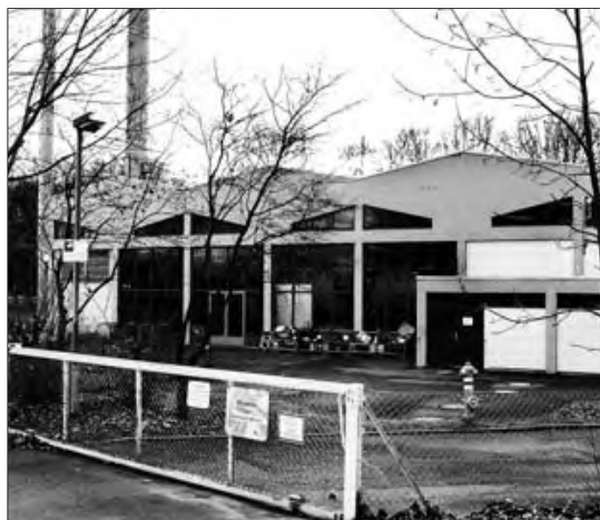
Der Endpunkt der Pipeline: das Biogas-Kraftwerk in Ölper.
