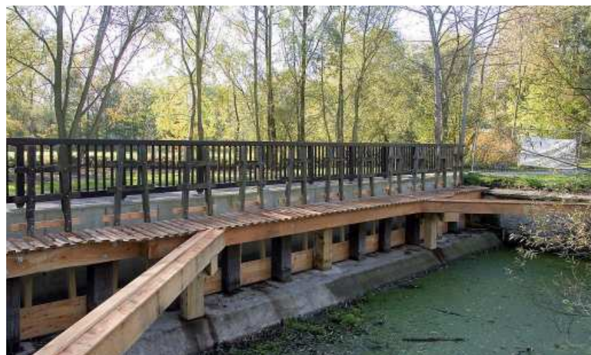
Das Ölper Freiflutwehr nach vollbrachter Restaurierung.
