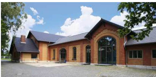
Das Wasserwerk am Bienroder Weg – Schauplatz des Workshops
