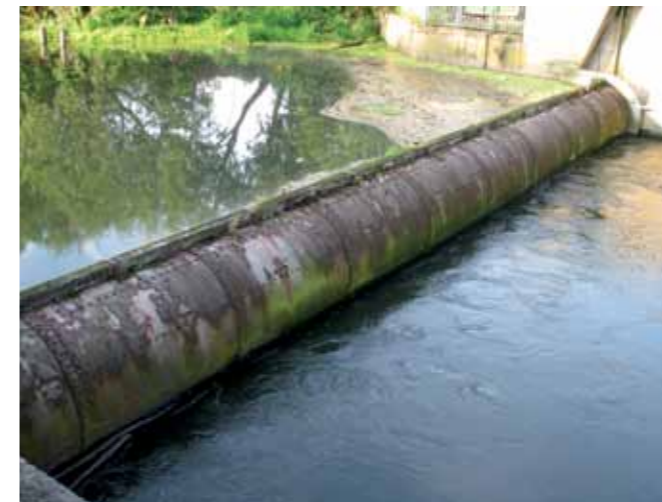
Die 70 Jahre alte Stahlwalze wird durch zwei Wehrtore ersetzt. Foto: SEIBS
